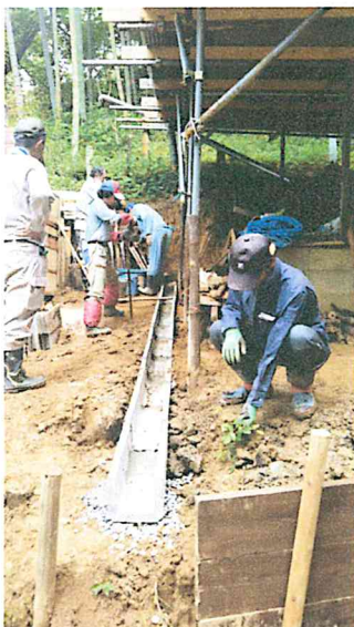
24. 窯の周囲にU字溝を設置
