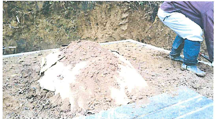
19. その上に旧窯から採取した焼き土 に を被せ る カケヤで叩き固める
