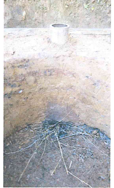
13. 木を燃やして排煙口を乾燥させる
