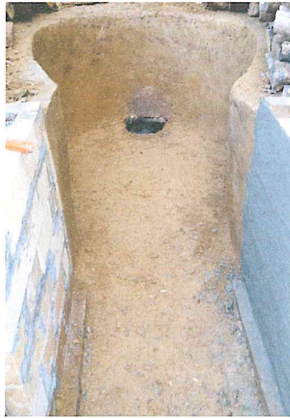
水抜きパイプを設置後土を埋め戻しガニ石上部も塞ぐ
