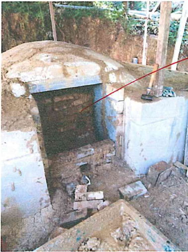
20. 障壁と炊き口を作り
