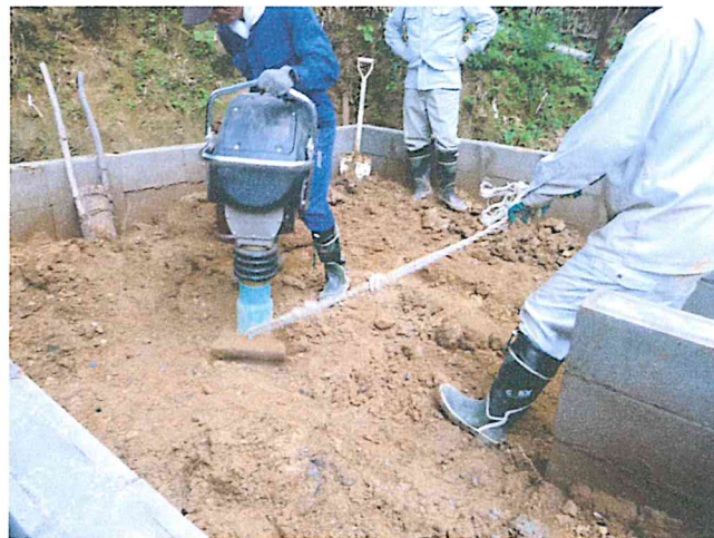
6. 積み上げたブロックの内側に石灰を混ぜた土を2〜30cm入れてはランマーで突き固めることをブロックの高さになるまで繰り返す
