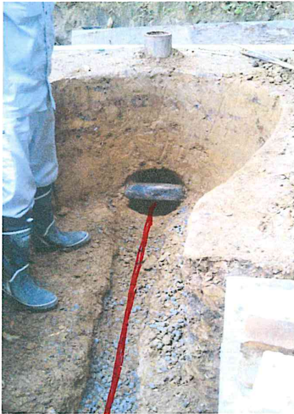
12. 排煙口から炊き口外部への水抜きパイプを設置する
