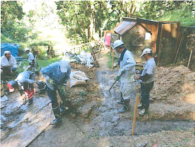
4. その上にセメントを流し込む
