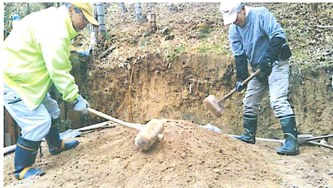
20. その上に旧窯から採取した焼き土を被せカケヤで叩き固める
