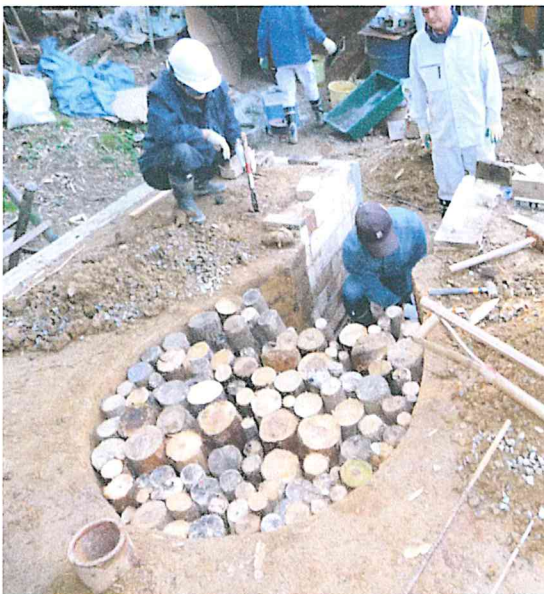
14. 窯内部に長さ70cmの丸太を縦にぎっしり詰める その上に窯天井の骨組みを作っていく
