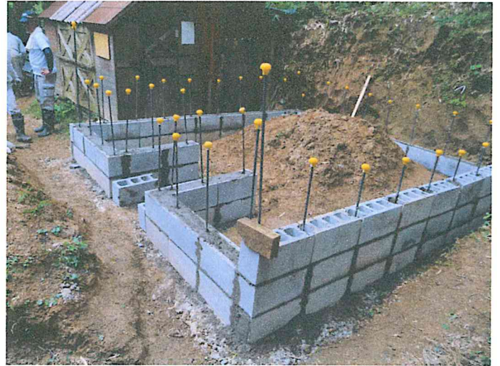
5. ブロックを4段積み上げる
